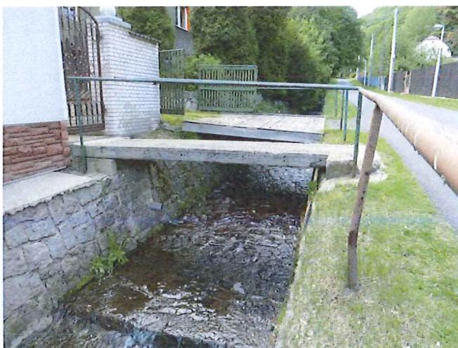
**Osecký potok** – betonový most a hlásný profil TE – 12 u objektu č.p. 2 na ř. km 3,56 v obci Hrad Osek ( kontrola a měření průtoku, čištění od naplavenin )
