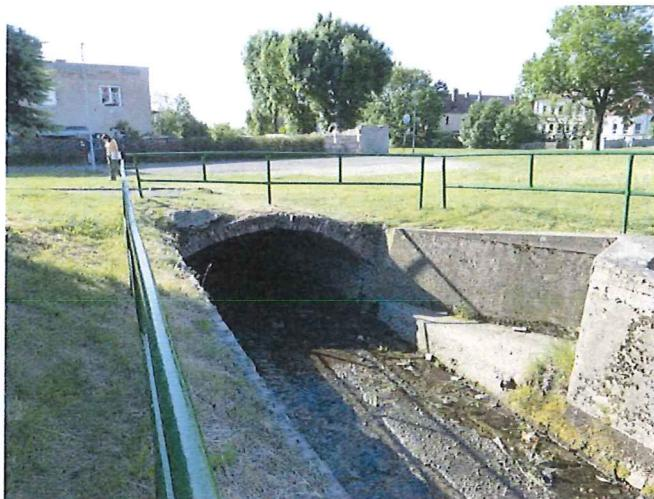
**Osecký potok** – betonový mostek a propustek u objektu č.p. 57 na ř. km 1,53 v obci Osek ( kontrola průtoku a čištění od naplavenin )
