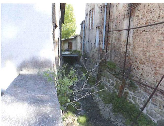
**Osecký potok** – propustek nad objektem č.p. 57 na ř. km 1,56 v obci Osek ( kontrola průtoku a čištění od naplavenin )
