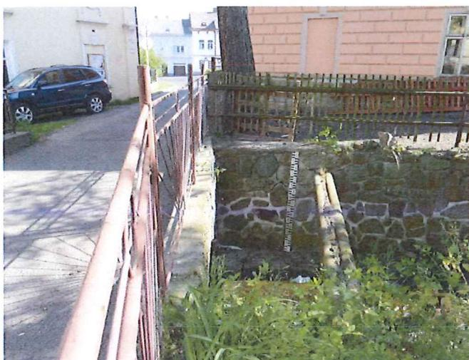
**Osecký potok** – propustek u objektu č.p. 49 na ř. km 1,69 v obci Osek ( kontrola průtoku a čištění od naplavenin )
