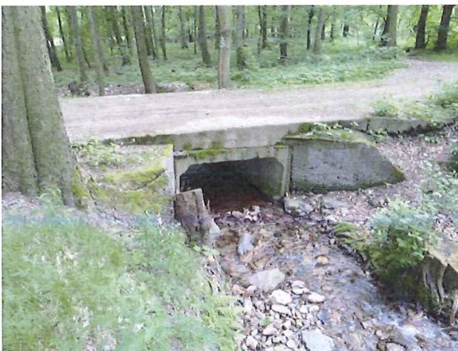
**Osecký potok** – betonový most na ř. km 3,00 v obci Osek ( kontrola průtoku a čištění od naplavenin )
