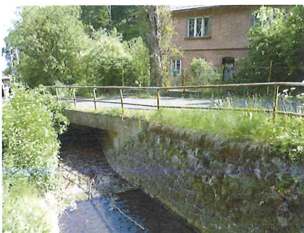
**Osecký potok** – betonový most a vodočet hlásného profilu na opěrné zdi u objektu č.p. 12 na ř. km 4,01 v obci Hrad Osek ( kontrola průtoku, čištění od naplavenin a měření průtoku z vodočetné latě )
